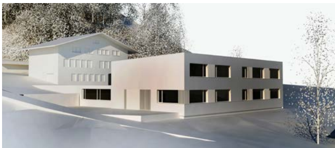
La commune de Hasliberg a centralisé l'ensemble de l'école, école enfantine comprise. Pour ce faire, elle a fermé deux sites dont les bâtiments avaient grand besoin d'être rénovés et a fait construire, sur un troisième site, un bâtiment indépendant pour venir compléter l'école datant des années 1950.
